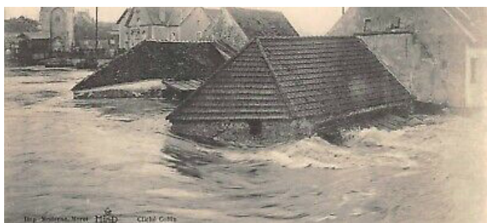
Inondations à Moret-sur-Loing en 1910
