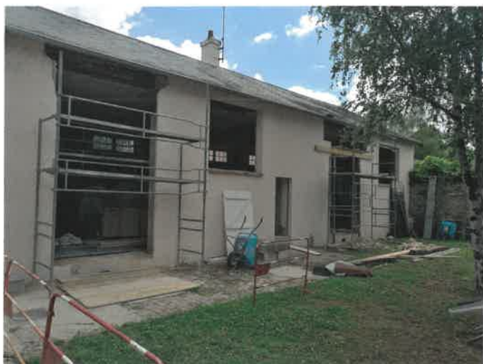
Travaux de la Mairie
