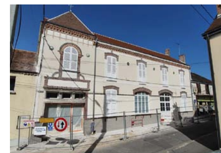
Installation de la rampe d'accès PMR.
