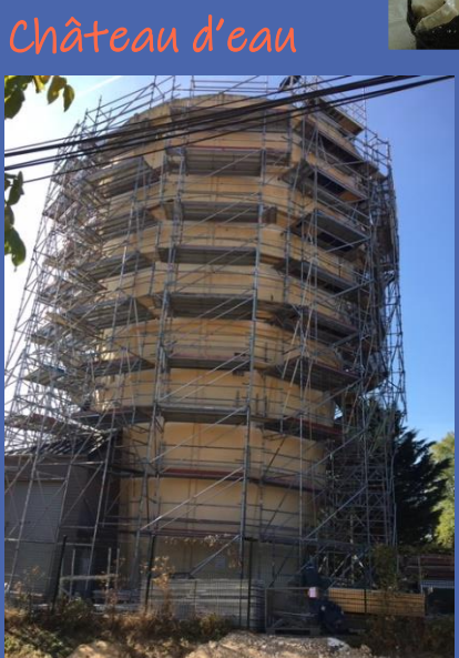
Travaux de réhabilitation du château d'eau effectués par l'entreprise Freyssinet pour un montant de 382 300 €.
